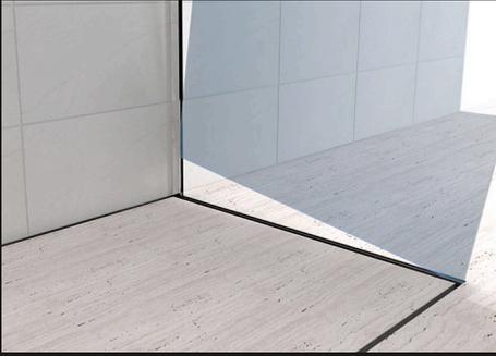
Fessure per l'inserimento dei vetri del box doccia vengono predisposte per una migliore tenuta strutturale, una migliore tenuta dell'acqua e per eliminare tutti i giunti in silicone a vista.
